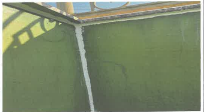
옥상 방수액 도포 및 실리콘 작업
