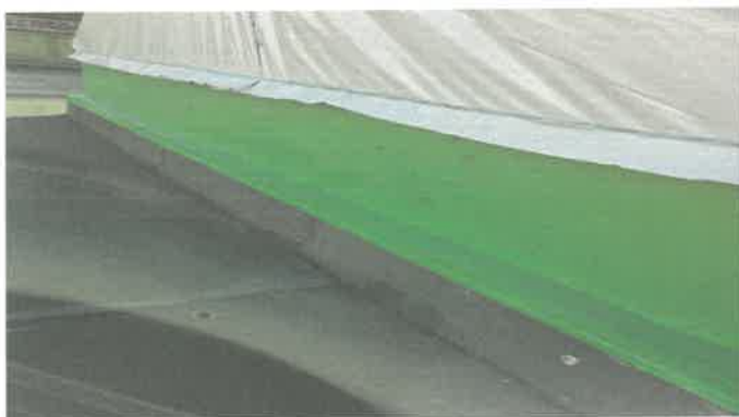
3층 헬스장 상부 외벽 방수
