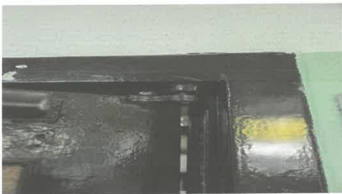
1층 청소년극장 출입문 경첩 보수
