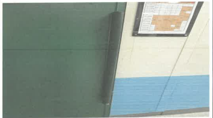
3층 아마테우스실 문턱 안전리브 보수
